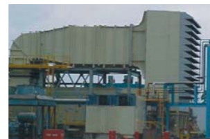
Donaldson liefert oft die Verrohrung für die Turbine zusammen mit dem Filter für alle Filtertypen an.
