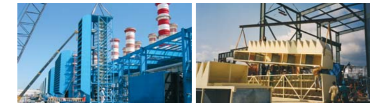
Die modulare Ausführung des Filtersystems macht die Aufstellung weltweit einfacher und schneller.
